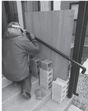
雪囲いの設置
